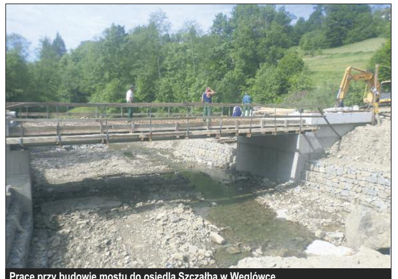
Prace przy budowie mostu do osiedla Szczalba w Węglówce
